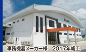
事務機器メーカー様 2017年竣工
