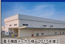
電子機器メーカー様 2015年竣工
