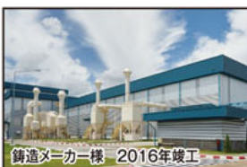
鋳造メーカー様 2016年竣工
