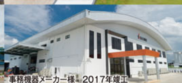
事務機器メーカー様 2017年竣工
